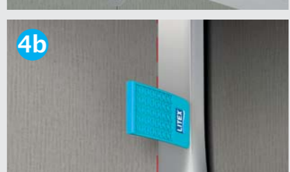
Mocowania śrub pośrodku płyty można alternatywnie zastąpić klejeniem punktowym; wtedy należy uszczelnić tylko łączenia.
