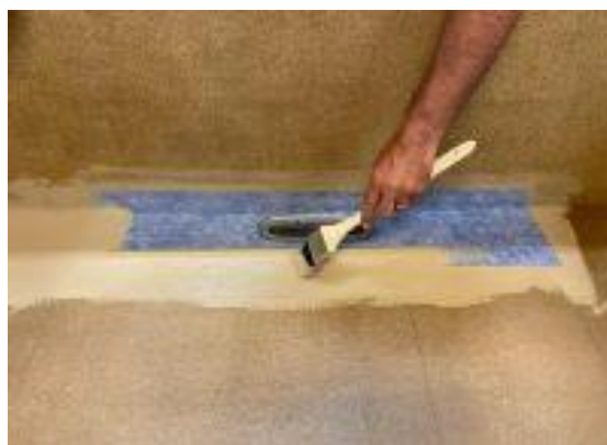
8. Applicera Litex Monteringslim på manschetten och Litex 2-Komponentslim på övrig golvyta. Montera Litex Folie och överlappa manschetten med minimum 50 mm.
