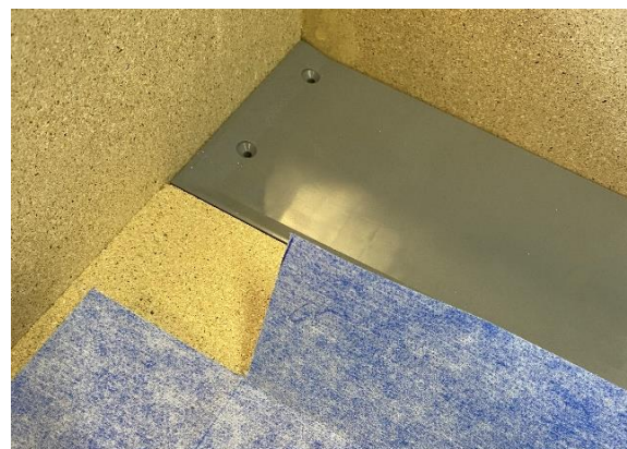
10. Vid hörnmontage, klipp bort överskottet på den blå brunnsmanschetten enligt bilden.
