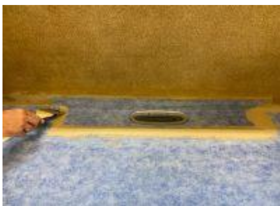
9. Förslut samtliga skarvar runt manschetten med Litex Monteringslim eller Litex 2-Komponentslim
