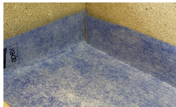
11. Vik upp manschetten och limma den enligt bild 5. Montera *innerhörns manschetten och limma det med Litex Monteringslim. Förslut skarvarna enligt bild 9.
